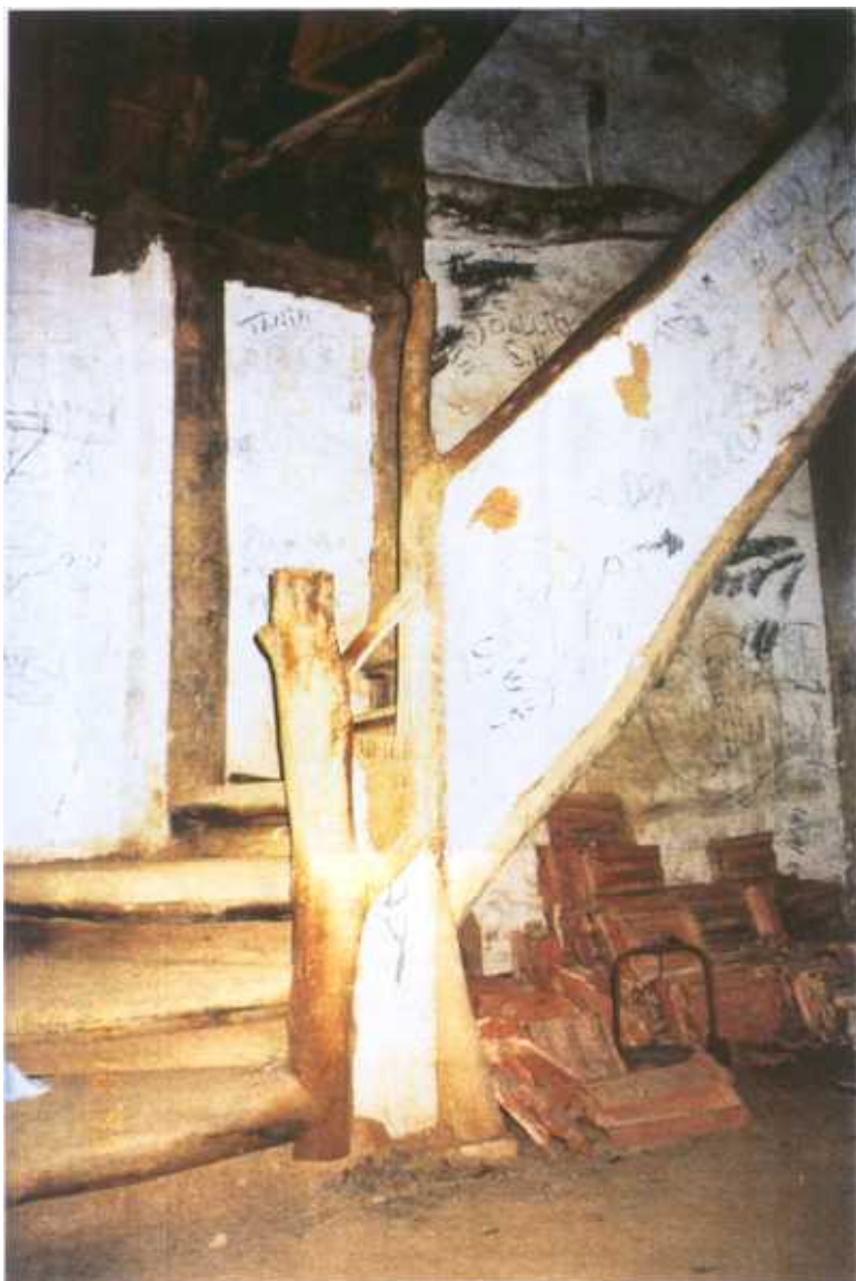
Fig. 8 e 9: Troncos com o formato natural no corrimão da escada, e janelas da sala de Beneficiamento
