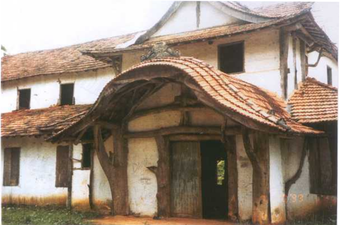
Fig. 2 Telhado "kara-hafu", no pórtico de entrada
