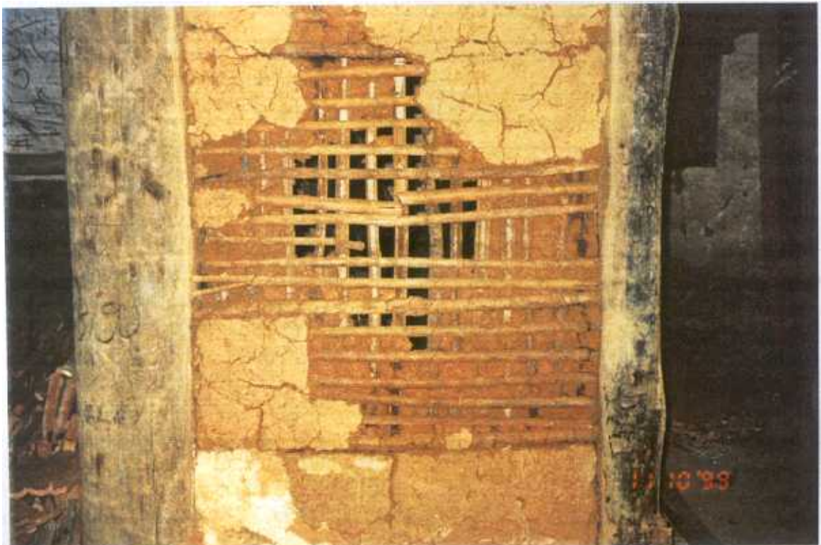
Detalhe de parede : bambu, sisal, argila misturada com vegetais (fibras)
