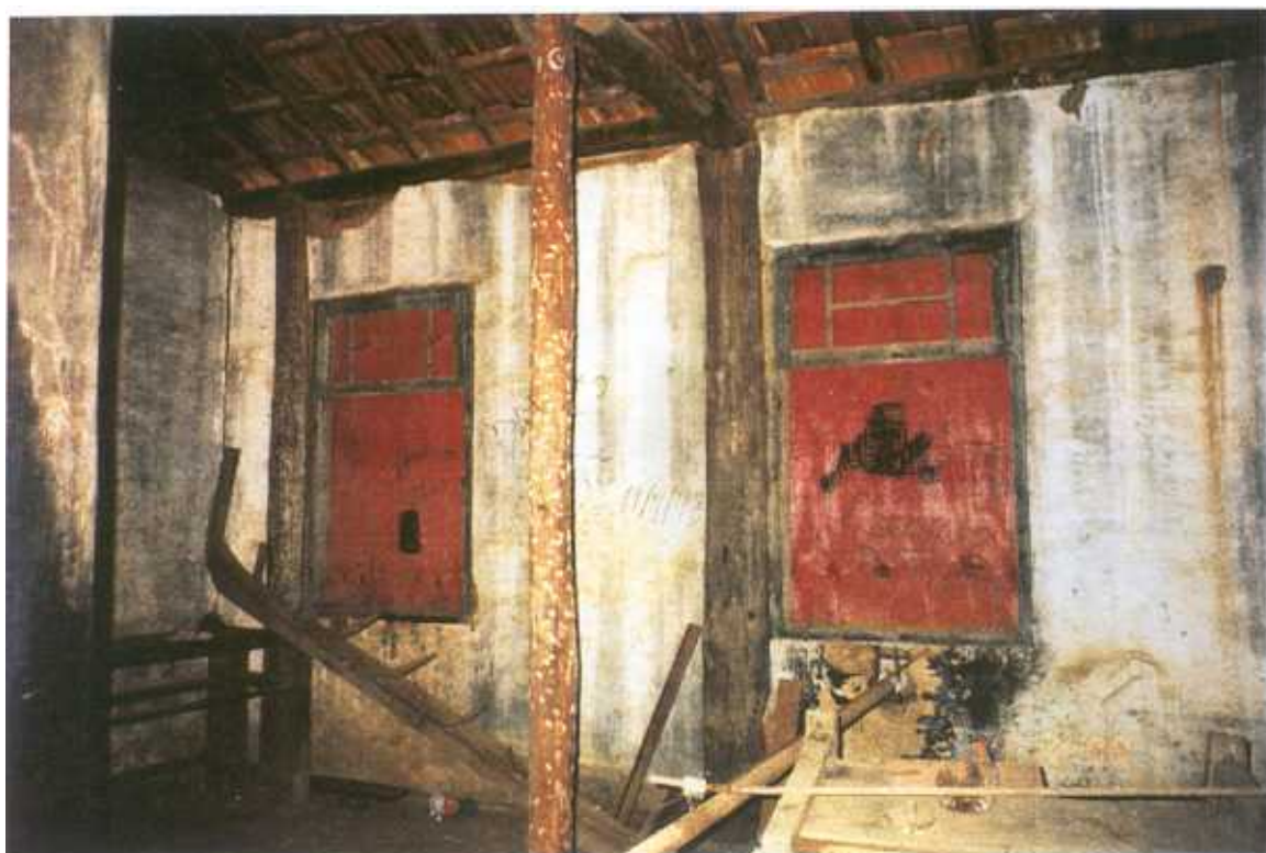
Fig 10 Janelas no ambiente do Deposito
