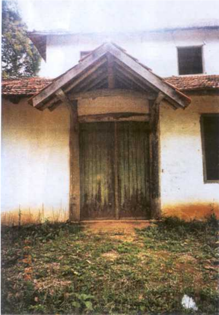
Fig 4 Pórtico da face sul com inclinação modificada
