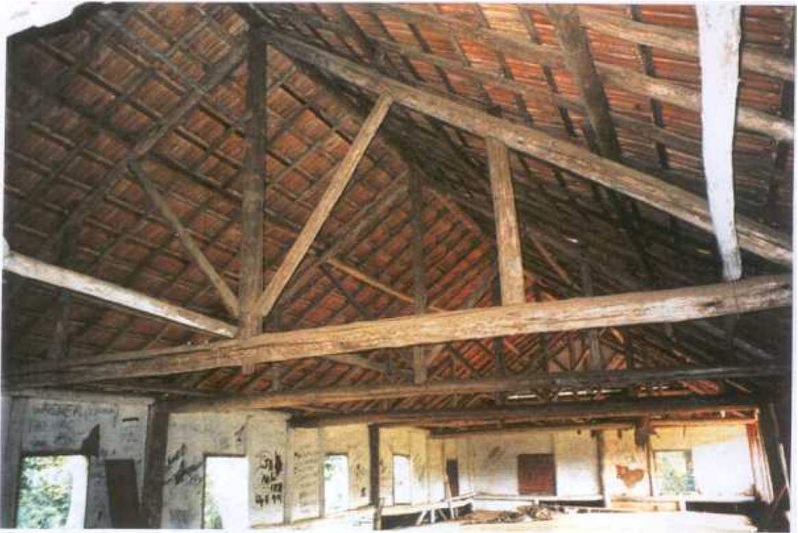
Fig. 1 Treliças planas à maneira de tesouras, na Sala de Desidratação, pavimento superior.
