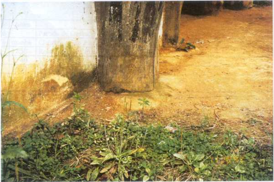
Fig. - 27 Base de pilar apoiada sobre pedra
