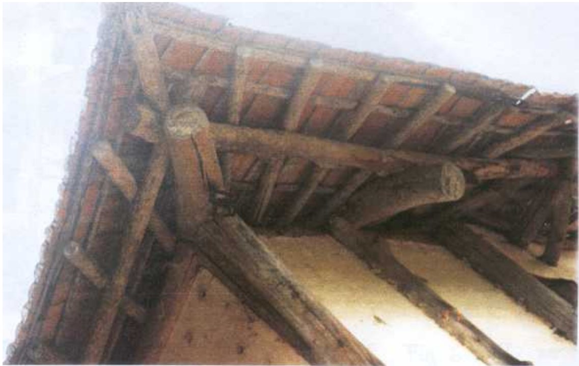
Fig 4 ougo-daruki beiral com cachorros mas paralelos, em forma de leque
